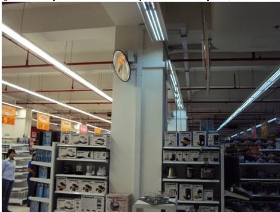
Figura 3.13 – Supermercado com iluminação fluorescente (esquerda) e LED (direita).
