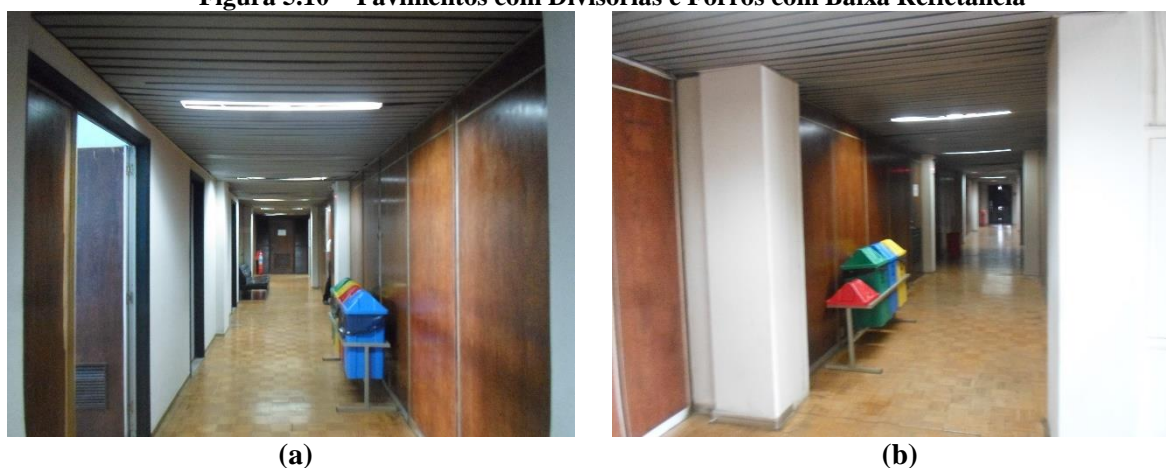
Figura 5.10 – Pavimentos com Divisórias e Forros com Baixa Refletância
