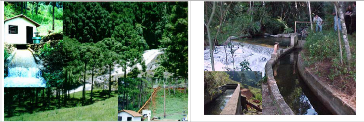
a) Conduto forçado e casa de máquinas
