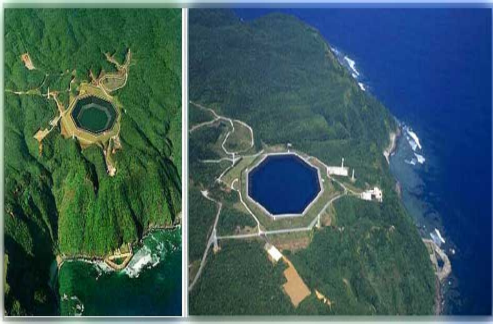
Figura 2.3 – Usina reversível de Yanbaru, Japão. (EPE, 2006d).
