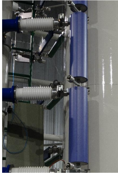
Figura 30 – Resistores de carregamento do Gerador de Impulsos do LEAT
