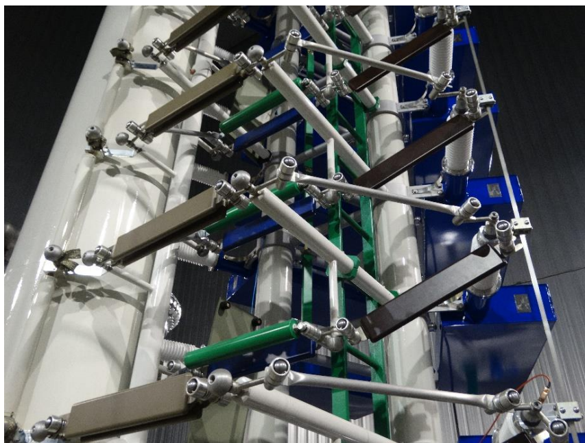
Figura 29 – Resistores de Frente e Cauda do Gerador de Impulsos do LEAT
